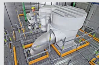
Ponteggi per l'industriale
