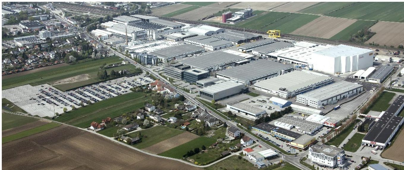
Sede centrale del gruppo Doka ad Amstetten
